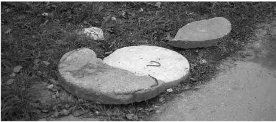
Заменена на новую сломанная крышка люка канализации около д.1-А по ул.Жмакина, обломки старого лежат рядом.
