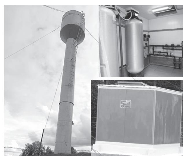
Антон Косяков. - В модуле находится запорная арматура, счётчик воды, две ёмкости, в которых формируется запас воды.
