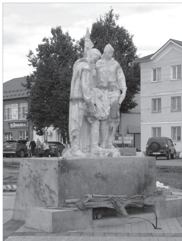
В процессе реставрации.
